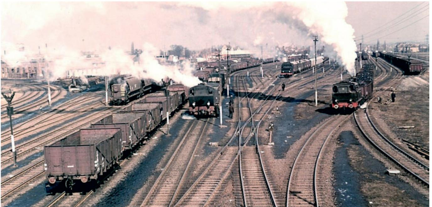
1954 beherrschte die Dampflokomotive noch die Szenerie. Blick vom Reiterstellwerk in den Nordteil des Rangierbahnhofes, der seit dem Spitzenjahr im KBE Güterverkehr (1957) über beachtliche 19, bis zu 600 m lange Aufstellungsgleise verfügte.
